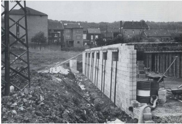
Construction du Pavillon du futur LTMA en 1968
