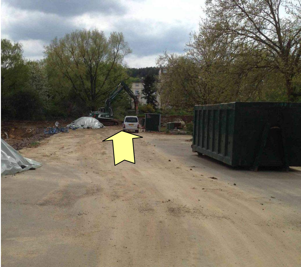
Emplacement de l'escalier d'entrée et du préau
